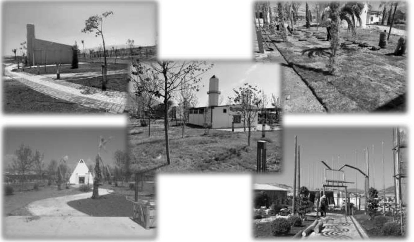
Hasancıklı Mah. EXPO Alanı 16 Adet Ülke Bahçeleri Peyzaj Uygulama Yapım İşi
