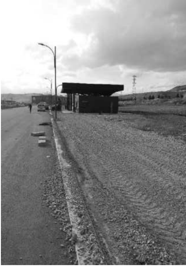
Hasancıklı Mah. (EXPO 2023) Anayol Çevresi Prekast Beton Bordür Tamirâtı (90 m 2 )
