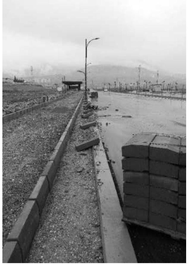
Hasancıklı Mah. (EXPO 2023) Anayol Çevresi Prekast Beton Bordür Tamirâtı (90 m 2 )
