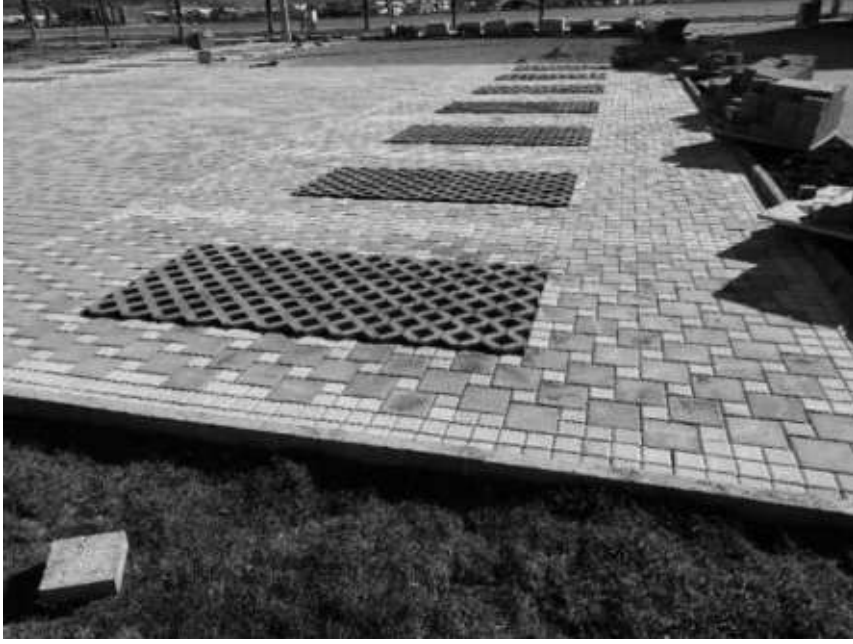
Hasancıklı Mah. EXPO Alanı İdari Bina Doğusu Otopark Yapım İşi (600 m2)
