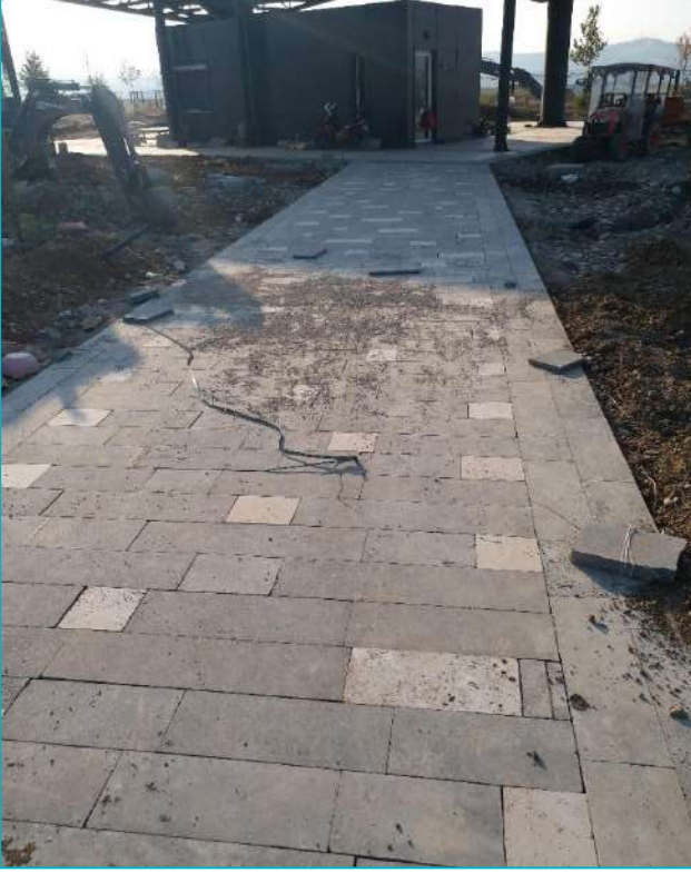
Hasancıklı Mah. Expo Alanı ve Çevresi Bazalt Tamiratlarının Yapılması (250 m2)
