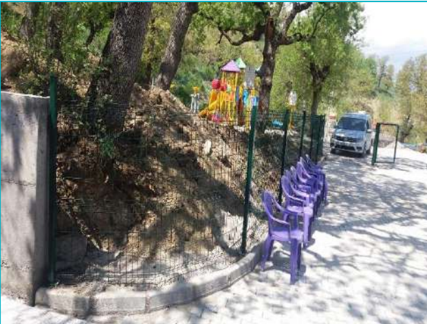
İlçe Sınırları İçerisinde Muhtelif Yerlerdeki Park ve Yeşil Alanlarımıza Tel Çit ve Panel Çit Uygulaması
