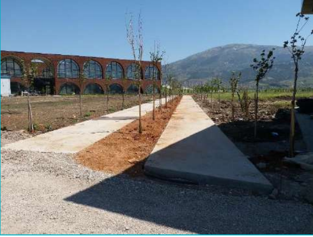
Hasancıklı Mah. Arasta Çevresi Yürüyüş Yolu Yapım İşi (800 m 2 )
