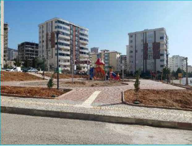
Hürriyet Mah. 34072 Sok. Park Yapımı (3650 m2)
