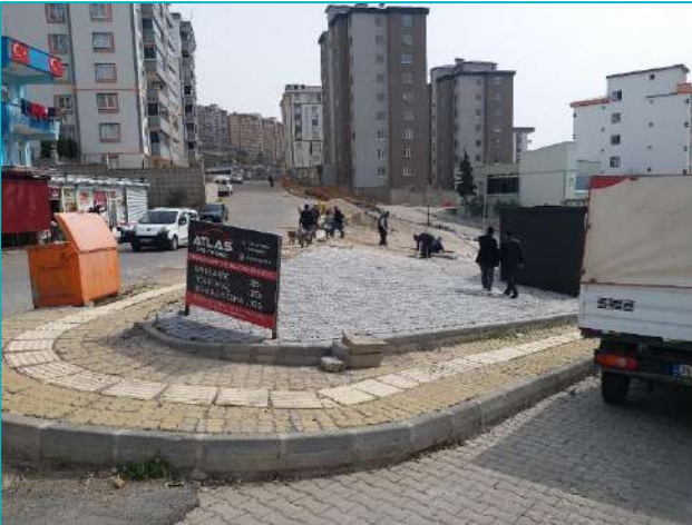
Saçaklızade Mah. 56073 Sok. Çevre Düzenlemesi (665 m2)
