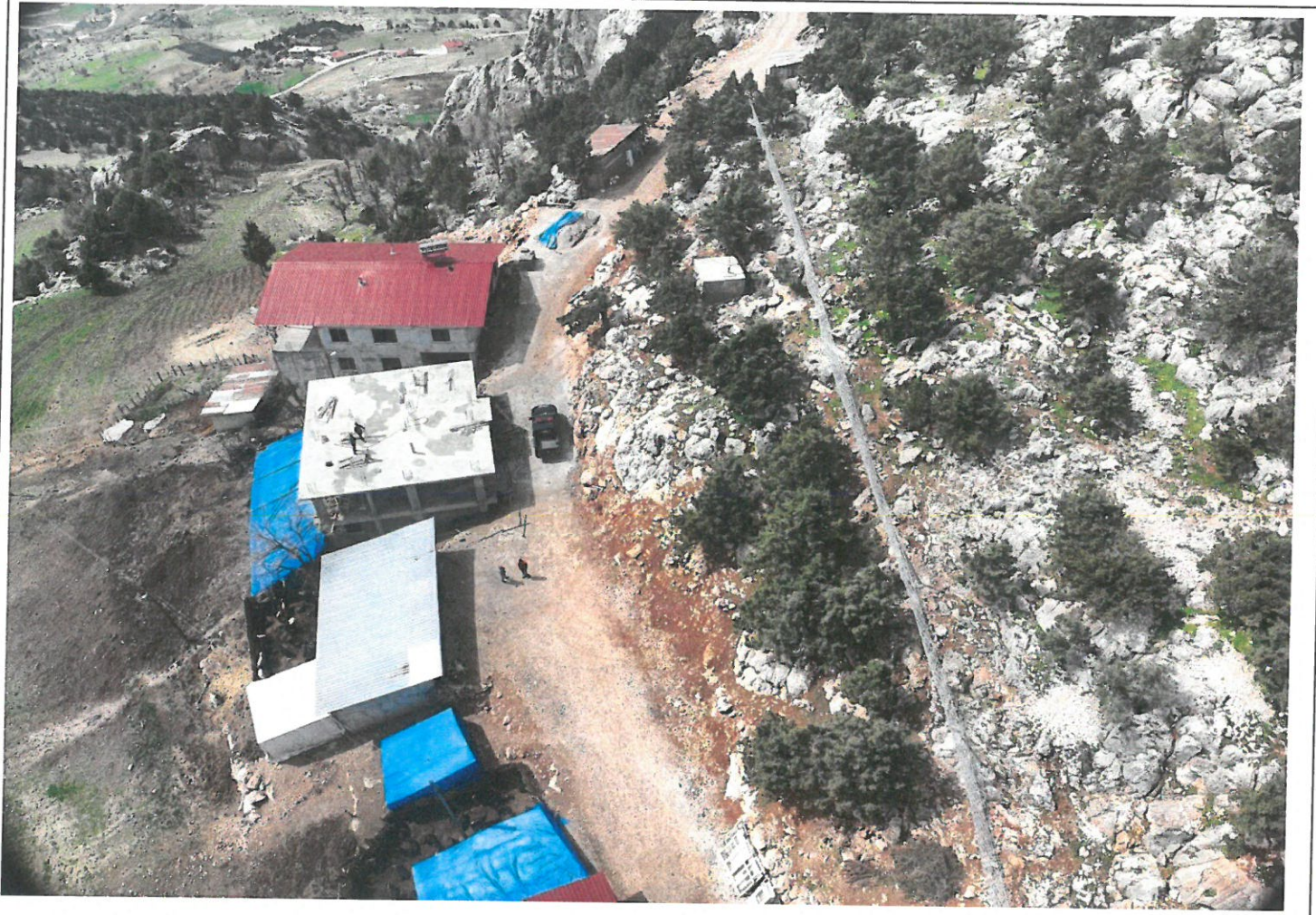
Şekil 4. Şahinkayası Beşpınar Mahallesi 2. Bölge Mevkiinde Bariyer Uygulaması
